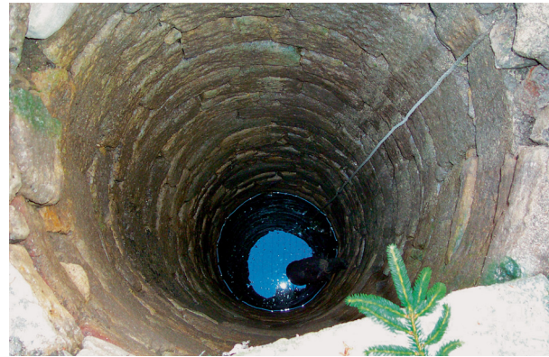
Abb. 11 Vachdorf, Kirchenburg, Blick in den aus Segmentsteinen gesetzten Brunnen, im Grund steckt noch der Rest eines Pumpenstocks.
