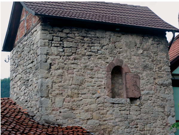
Abb. 6 Vachdorf, Kirchensburg, Torhaus, alter Eingang in die Torstube
