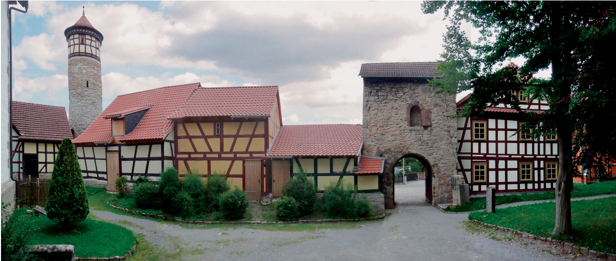
Abb. 10 Vachdorf, Kirchenburg, Ansicht der restaurierten Nordseite des Kirchhofes (2010) mit Hutturm, Gaden, Innentor und der alten Schule, jetzt Gemeindeamt
